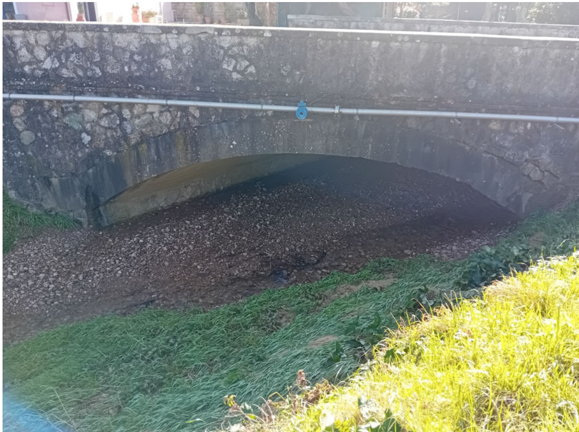
Rio Vaiano – Attraversamento 10 – vista da valle – Arco ribassato
