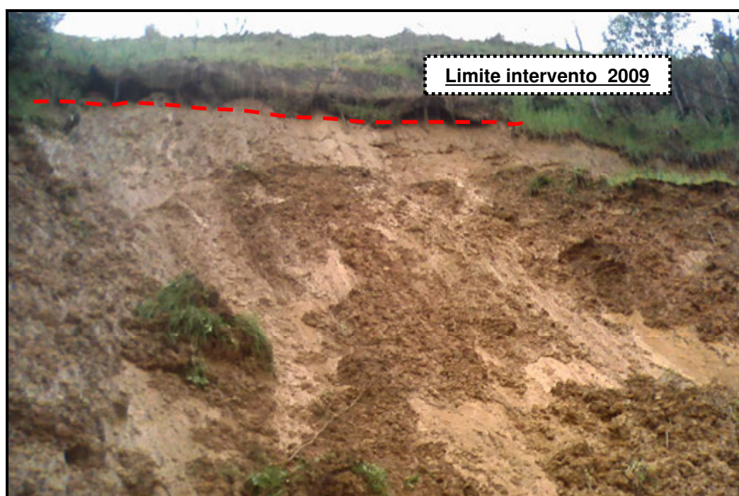
Foto n° 4 – scarpata e corpo di frana
